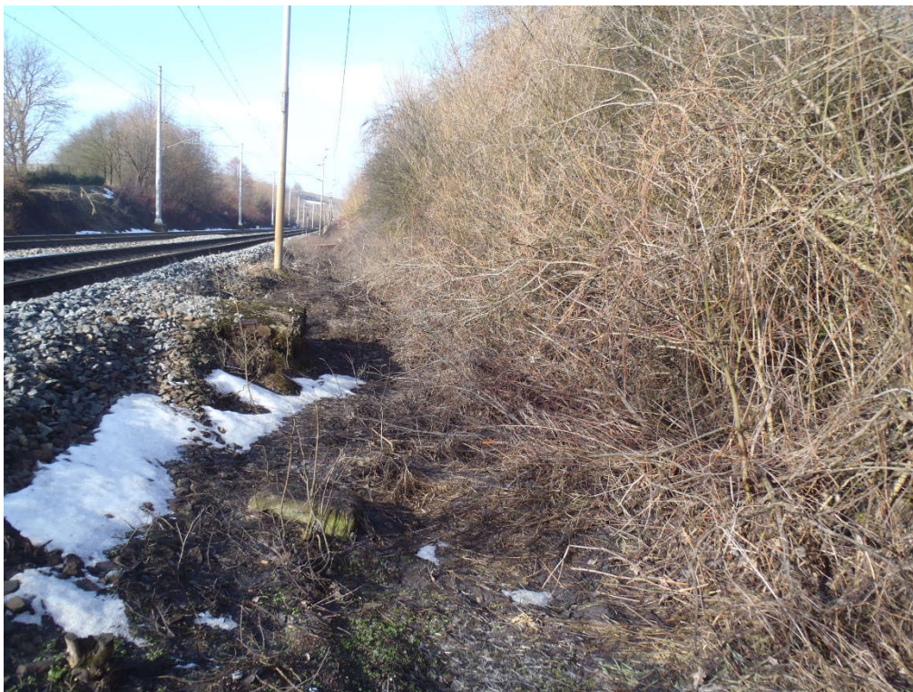
Foto 3 – Odvodnění na straně 2. koleje je rovněž nefunkční, zcela zarostlé vegetací. V současnosti voda vytékající ze zářezu nasycuje těleso náspu
