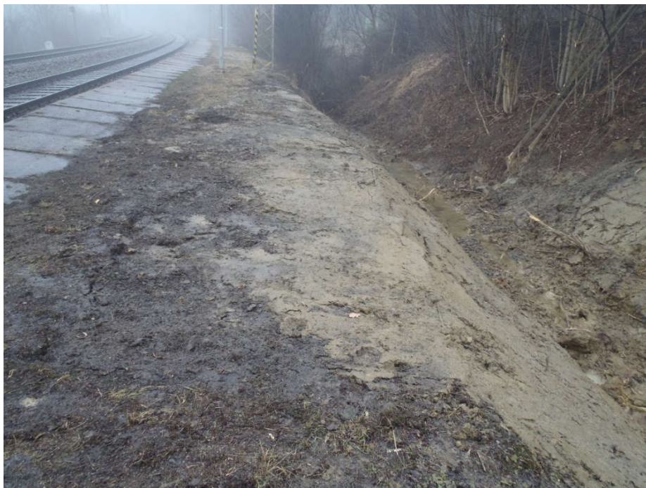
Foto 1 Na straně odřezu byl pročištěn odvodňovací příkop a terén upraven
