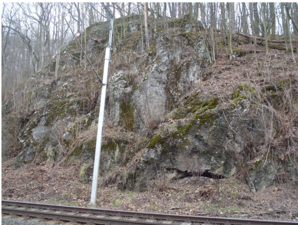
Foto č. 5-6 – Skalní odřez trati s bloky devonských vápenců, s vegetací a kořenovým systémem na diskontinuitách v km 5.300
