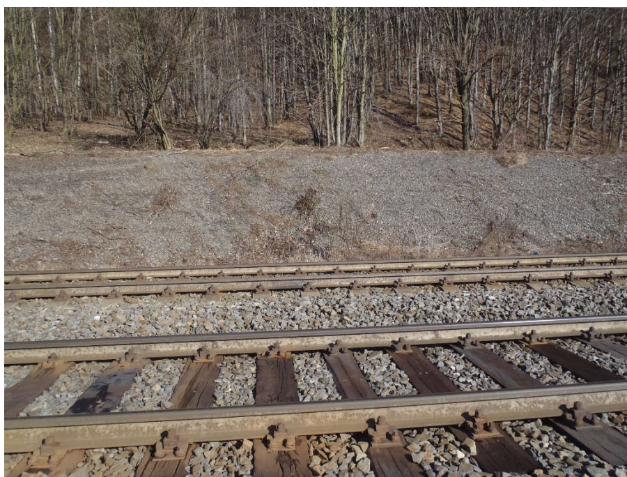
Foto 2 - Přítěžovací lavice v čele stabilizovaného sesuvu č. 16
