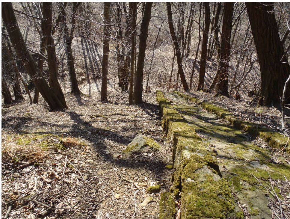
Foto 3 - Odvodnění paty sesuvu č. 11 sběrnými kamennými žlaby
