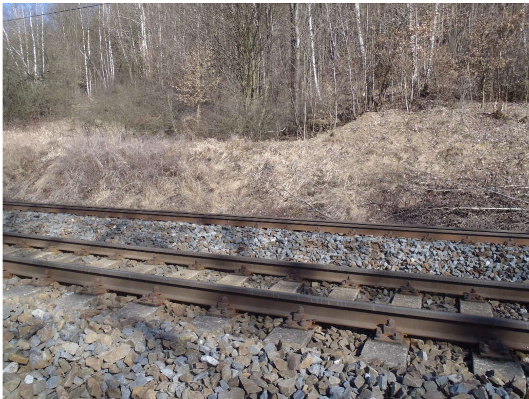
Foto 1 Dočasně stabilizovaný sesuv nad tratí v km 27.200-27.300 vykazuje pouze mírné vyboulení čela sesuvu
