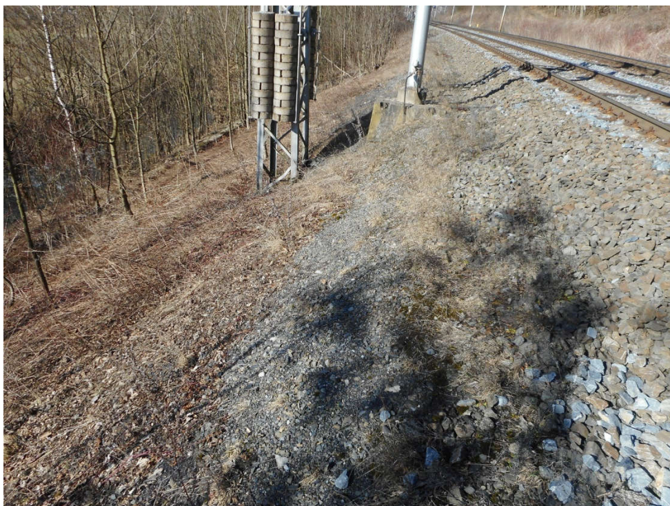
Foto 2 V km 31.5-31.6 proběhla v minulosti stabilizace porušeného náspu. Násep nad opěrnou zdí ani odřez železniční trati nejeví v současnosti známky nestability.
