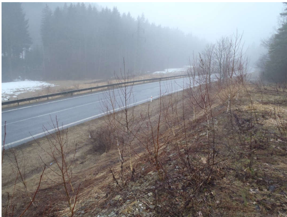
Foto 1 – Pohled na přitěžovací lavici na čele aktivního sesuvu č. 53b
