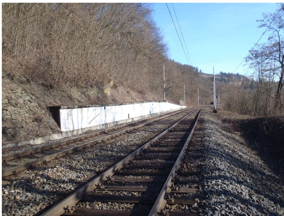
Foto 4 - Opěrná a zárubní zídka v km 31.488-31.558
