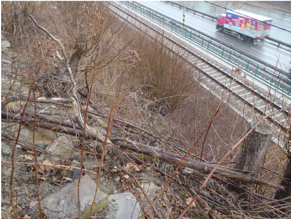
Foto 2 – Uvolněné bloky pískovců v místě přístupové cesty na svahu nad tratí představují potenciální nebezpečí pro trať
