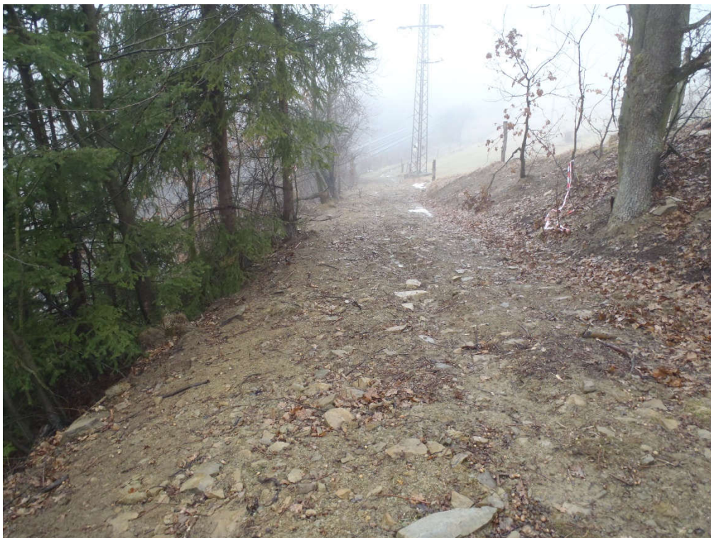
Foto 1 Pohled na sanovaný úsek zářezu nad tratí v km 21.95
