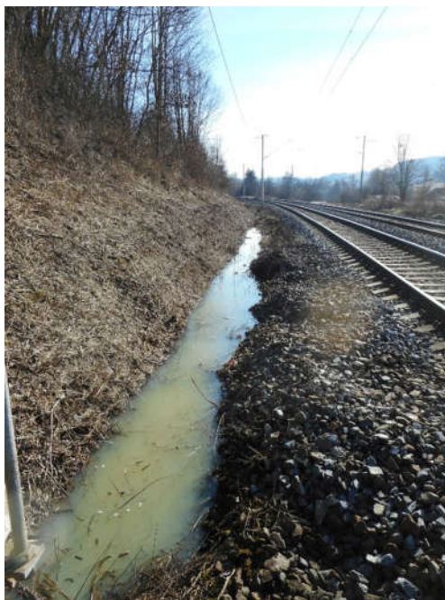
Foto 1-2 Nefunkční odvodnění v odřezu trati v km 33.550 – 33.625
