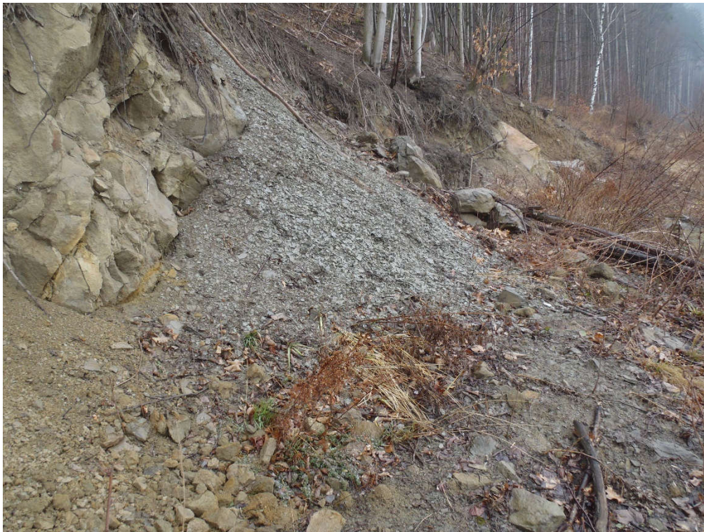
Foto 1 - Odřez přístupové lesní cesty nad tratí může vyvolat sesuvy menších rozměrů a skalní řícení
