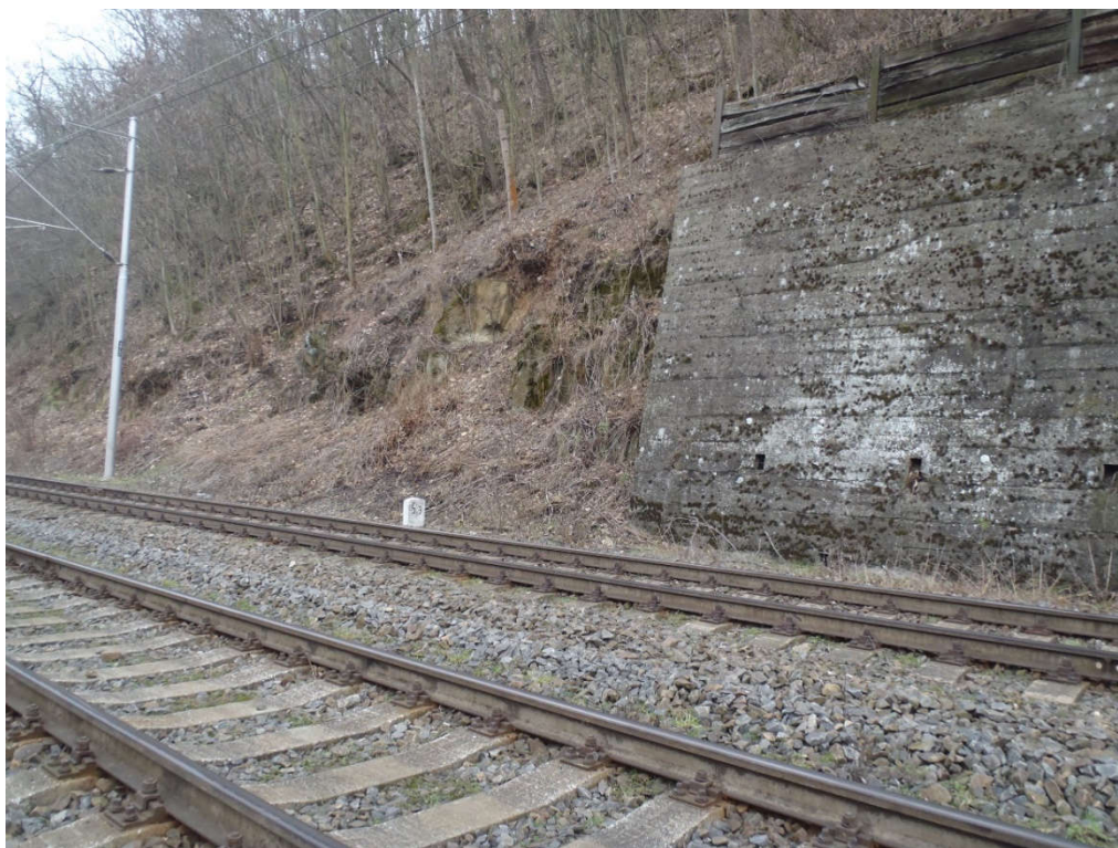
Foto č. 3 – Nezabezpečený úsek trati před opěrnou zdí ve staničení km 5.300 s bloky nestabilních pískovců, které mohou ohrožovat vypadáváním trať
