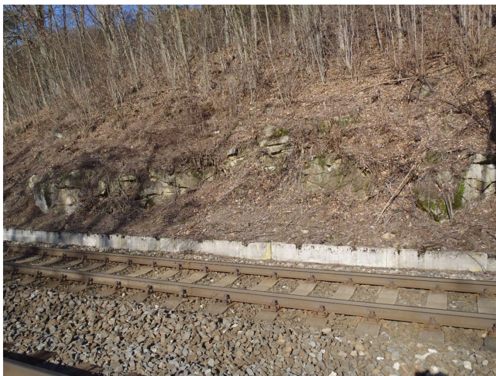
Foto 4 - Pohled na čelo sesuvu č. 14 s akumulací hmot nad tratí v km 31.450
