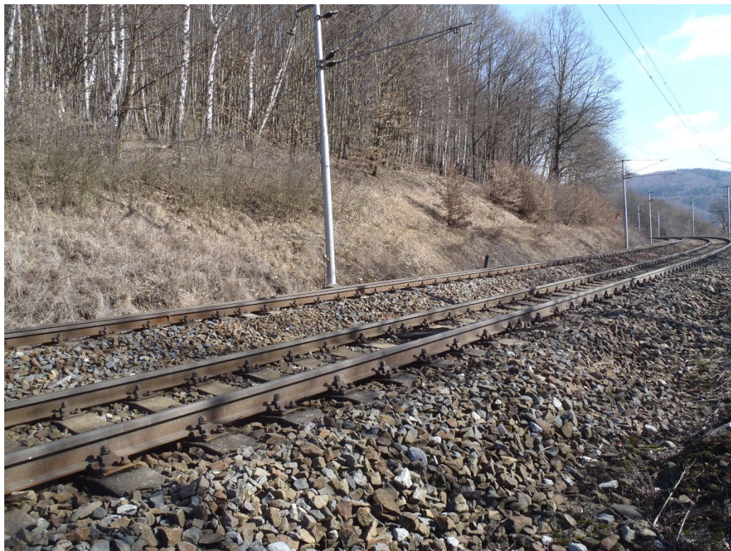
Foto 1 Dočasně stabilizovaný sesuv s přítěžovací lavicí a čelem zasahujícím k trati v km 25.400 – 25.600
