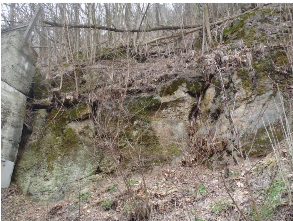
Foto č. 1 a 2 – Nezabezpečený úsek trati v úseku za opěrnou zdí v km 5.370. Odřez trati je veden v pískovcích a slepencích spodnokarbonského stáří se systémem kolmých puklin
