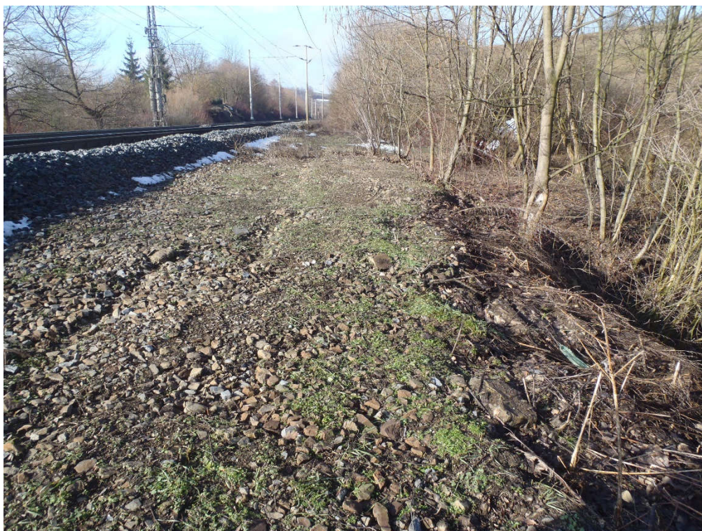
Foto 1 – V místě deformací a poklesů náspu v km 26.320-26.350 byl násep v nedávné době dosypán hrubým kamenivem a zhutněn
