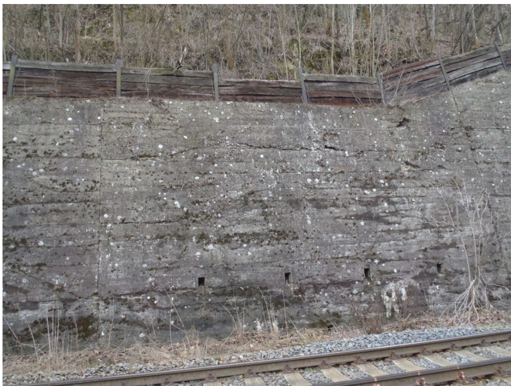
Foto č. 4 – Opěrná zeď v km 5.300-5.370 jeví známky deformací a opotřebení
