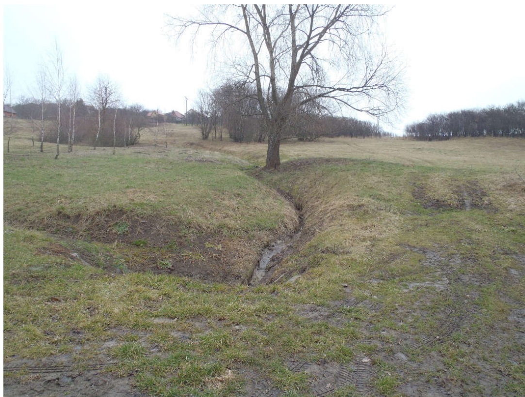
Foto 1 – Funkční odvodnění čela sesuvu ev. č. 28
