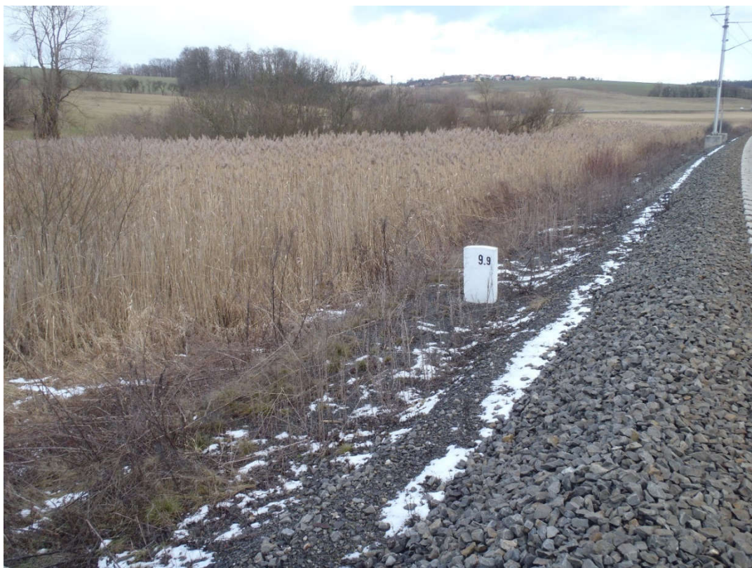
Foto č. 1-2 – Pohled na zamokřené území po obou stranách trati v kritickém úseku poruch drážního tělesa (km 9.948-9.525)
