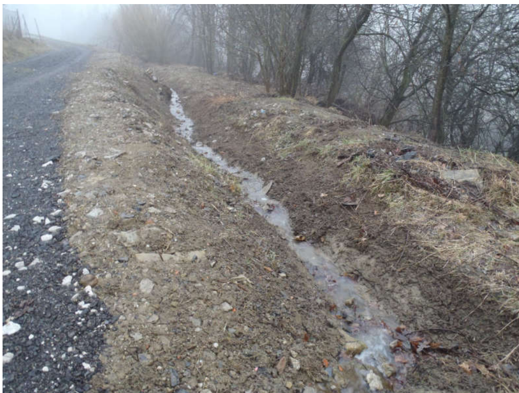
Foto 3 V prostoru sanovaného zářezu nad železniční trati byla vybudována cesta a odvodňovací příkop
