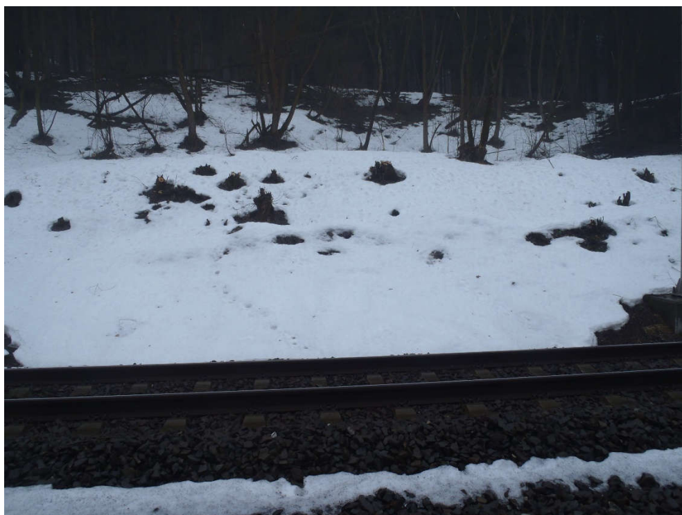
Foto 1 Dočasně stabilizovaný sesuv v odřezu trati v km 25.700-25.730
