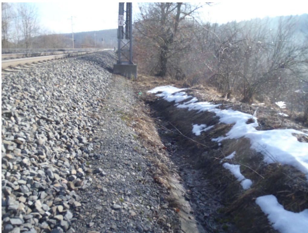
Foto 2 – Pohled na nefunkční vyústění odvodnění na straně 1. koleje (končí na tělese náspu)
