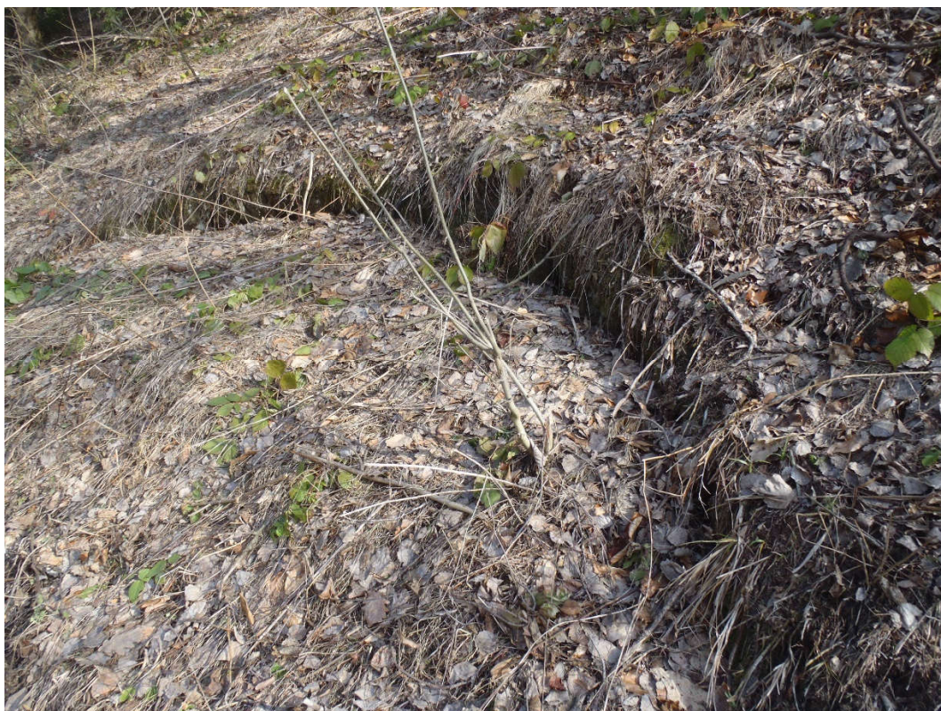
Foto 4 – V sanovaném úseku odřezu trati se začínají tvořit zátrhy (v délce 10 m, výška trhlin 30 cm)
