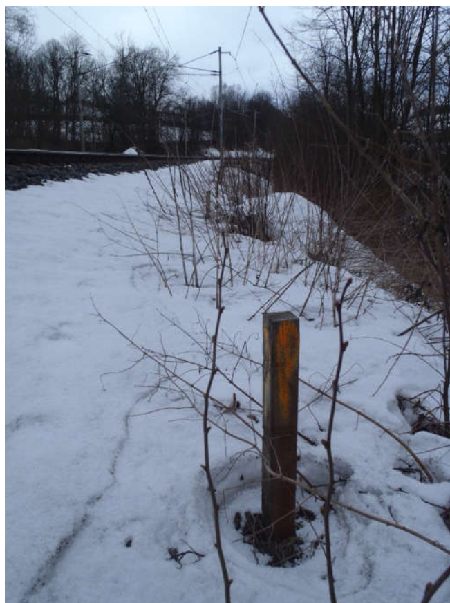
Foto 2 – Deformace náspu byly v minulosti pravděpodobně sledovány systémem geodetických bodů
