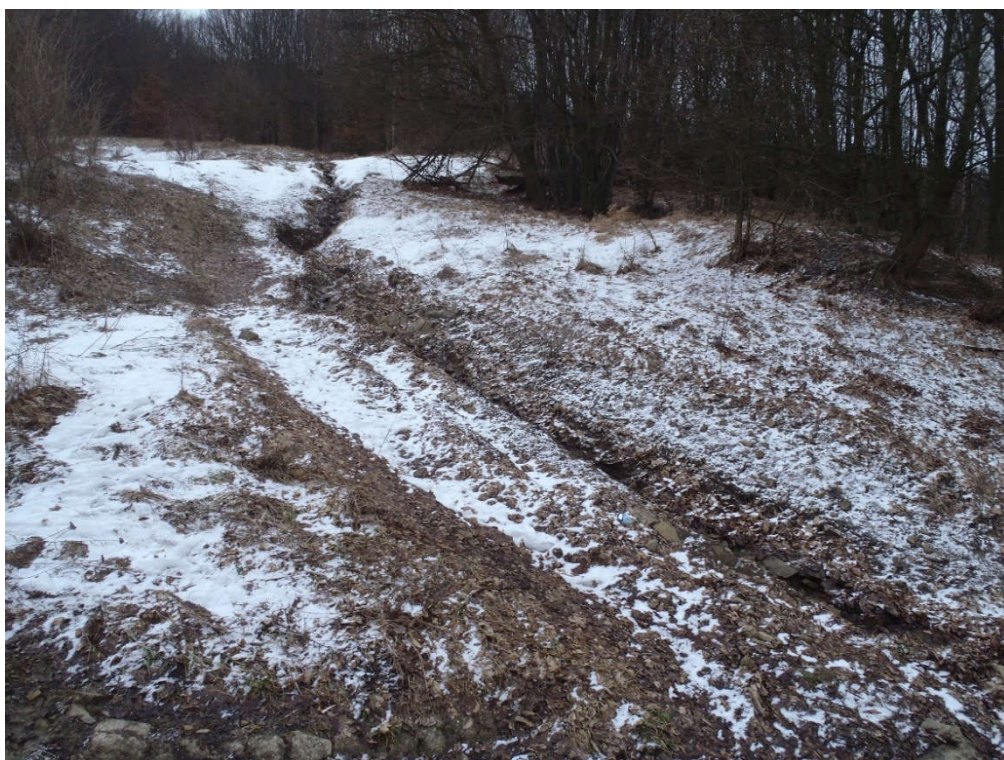
Foto 4 – Lesní cesta funguje jako odvodňovací prvek a účinně odvádí povrchovou vodu ze sesuvného svahu nad tratí
