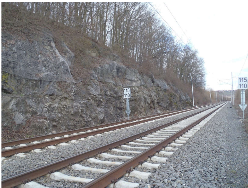
Foto č. 3 - Skalní odřez trati v km 9.400-9.530 vedený v devonských vápencích je zabezpečený přikotvením bloků a kari sítěmi
