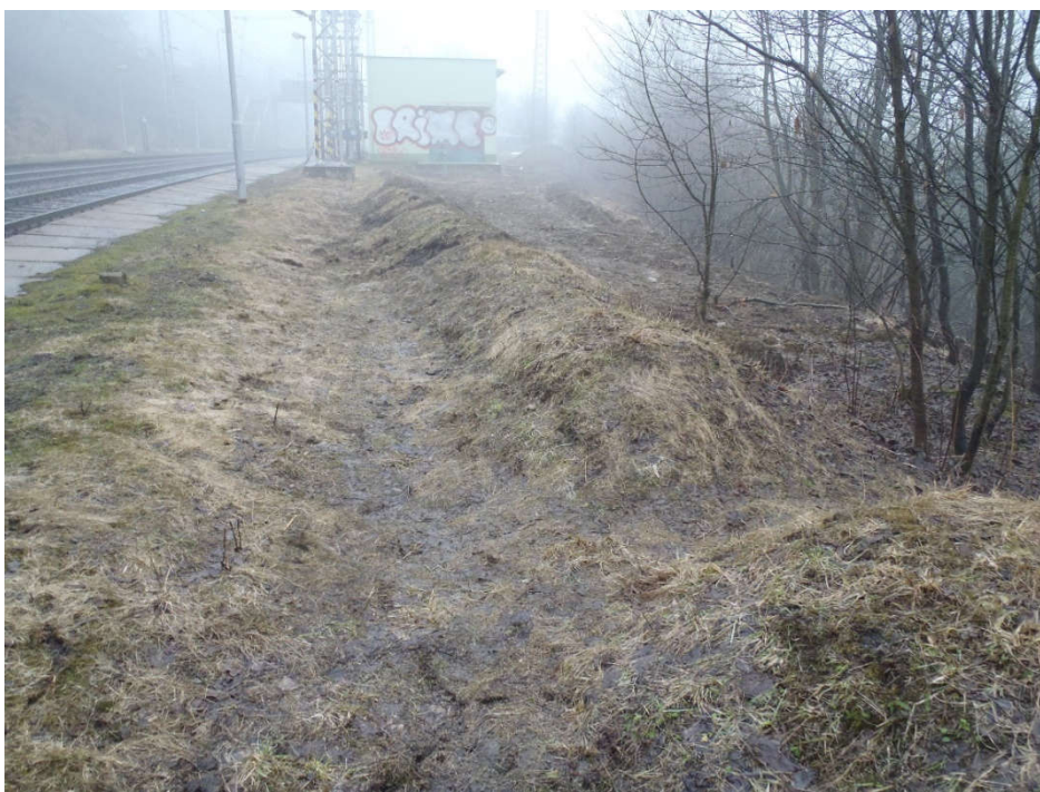
Foto 2 Pohled na porušený násep s valem a deformacemi na straně 1. koleje
