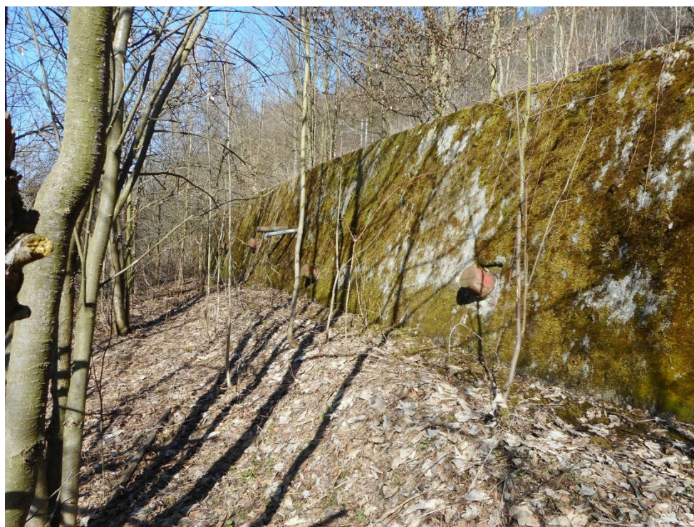
Foto 1 Sesuvné území č.73 a železniční trať je v km 31.400 – 31.700 zabezpečena kotvenou opěrnou zdí s odvodněním
