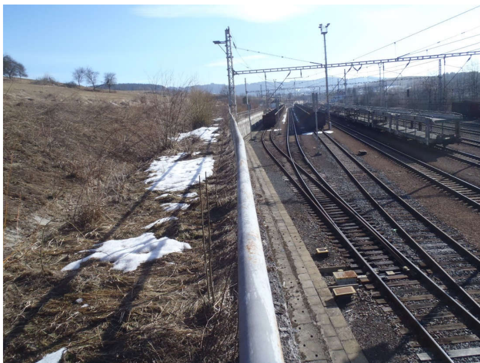
Foto 1 – Sesuvný svah je zabezpečen masivní opěrnou zdí a nevykazuje deformace.
