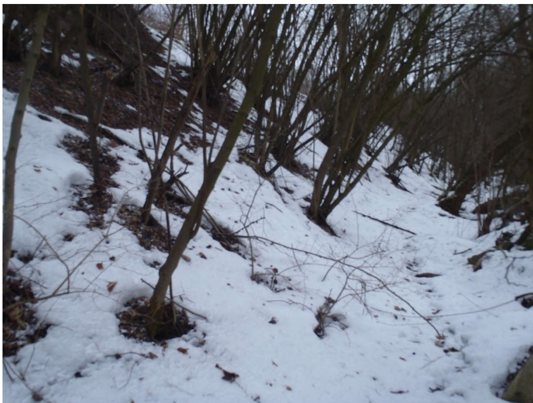
Foto 1 – Deformace náspu se projevují na straně 1 koleje nakloněnými stromy
