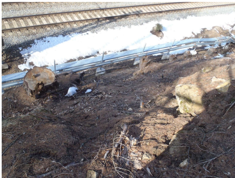
Foto 1 – Čelo aktivního sesuvu č. 4a zasáhlo v nedávné době až k trati a vyžádalo si kromě sanace čela i přeložky drážních sítí nad terén
